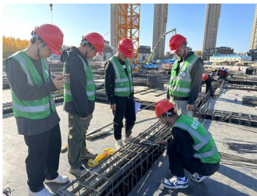
图 2 学生进行钢筋绑扎
