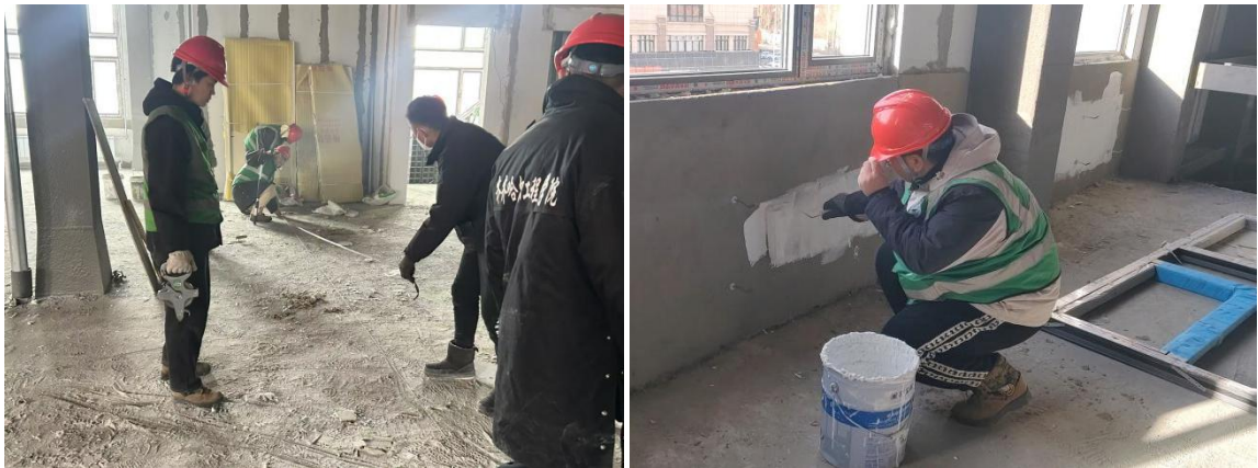
图5 学生参与到知甘堂项目建设中
